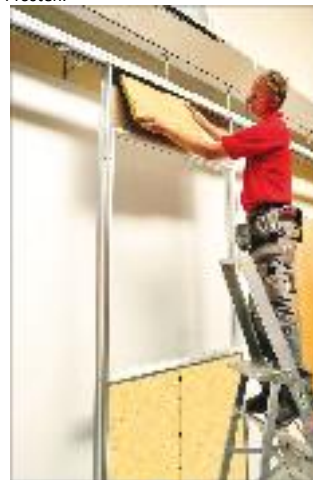
Montieren Sie jetzt an der anderen Seite die beiden anderen maßgeschnittenen Platten, genau wie die letzte Platte, im Ober- und Unterprofil.
