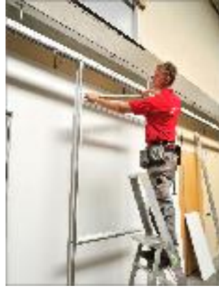
Drücken Sie den Querträger gut auf den Pfosten und stellen Sie das Glaselement mit den Stellmuttern ein.
