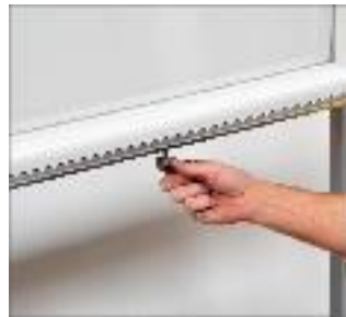
Schieben Sie jetzt an einer Seite die maßgeschnittene Ober- und Unterplatte in das Fußboden- und Deckenprofil.
