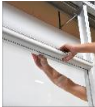
Drücken Sie den Querträger gut auf den Pfosten und stellen Sie das Glaselement mit den Stellmuttern ein.
