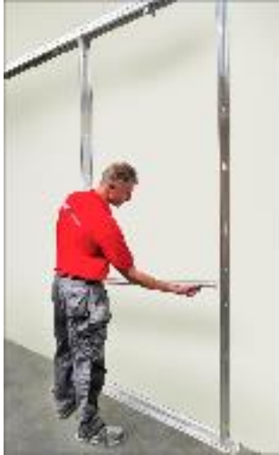
Profilpfosten in der richtigen Lochung einen Alu-Querträger (D.M.S.).
