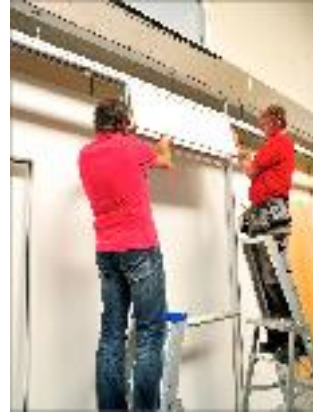
Montieren Sie, wenn nötig, einen Zwischenpfosten in der Mitte der Wand.
