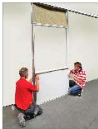
Schieben Sie jetzt an einer Seite die maßgeschnittene Ober- und Unterplatte in das Fußboden- und Deckenprofil.
