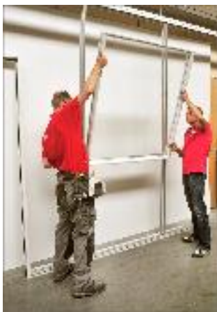
Montieren Sie das Glaselement, indem Sie es quer auf den Querträger stellen.
