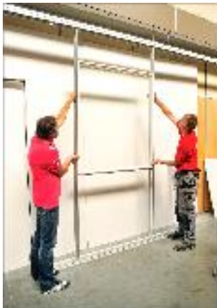
Anschließend drücken Sie den Pfosten fluchtend mit den H-Profilpfosten und montieren Sie den zweiten Alu-Querträger (Modell D.M.) auf das Glaselement.
