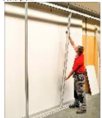
Montieren Sie zwischen diesen H-Profilpfosten zwei Alu-Querträger, einmal Querträger Modell D.G.W. und einmal Querträger Modell D.B.S.
